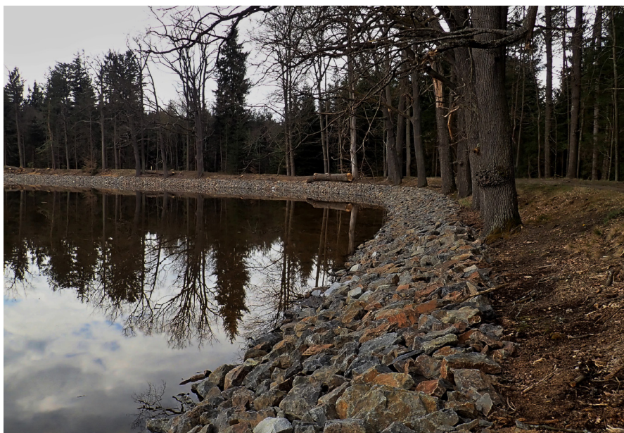
Obr. 6: Kamenný zához na návodní straně hráze. Chybějící ekoton přechodu vody na souš je smrtící past pro larvy vodních brouků, které se kuklí na souši. Foto V. Kolář
