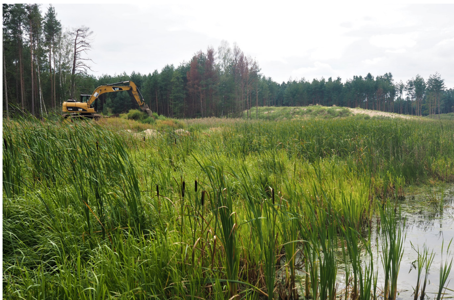
Obr. 7: Těžká technika na podzim 2020 odstraňující deponie z jižních zátok. Foto V. Kolář
