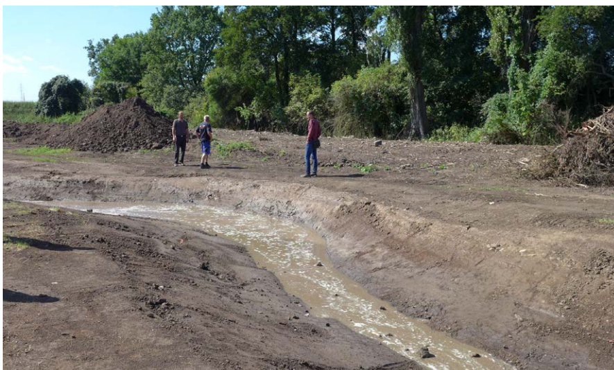
Září 2019. Město Praha dokončuje revitalizaci úseku Řičanky pod Dubčí. Mohutná napouštěcí vlna postupuje novým korytem Řičanky. Celá okolní niva je v majetku města Prahy a bude ponechána přirozenému vývoji potočního pásu. Foto Tomáš Just
