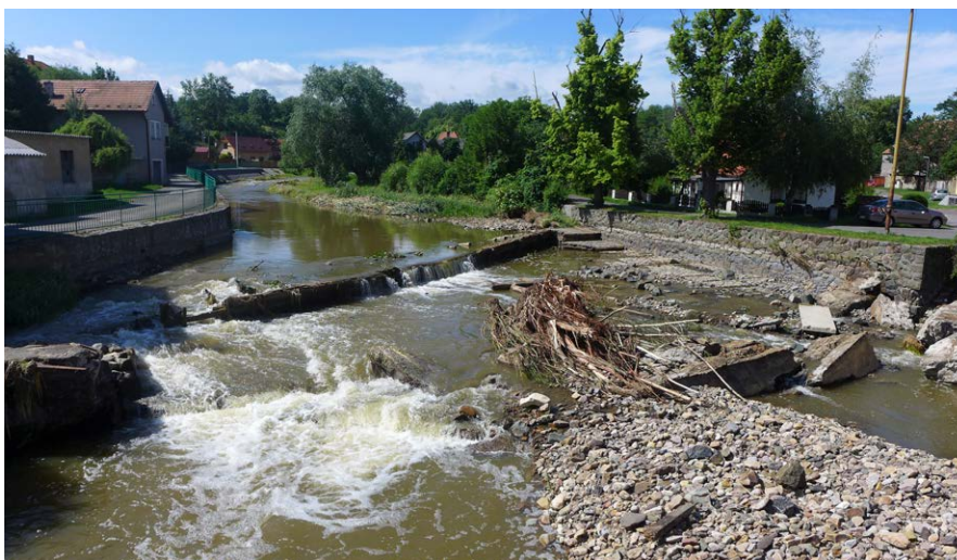
V roce 2018 svalila povodeň jez na Litavce v Lochovicích. Cenný příspěvek k renaturaci vodního toku a ke zlepšení podmínek průběhu povodní obcí. (Událostí se obnažil starý, nízký jez ze dřeva.) Foto Tomáš Just
