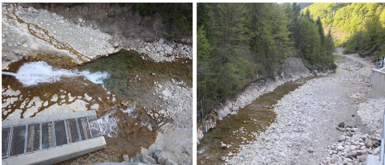
Obr. 3 Vodní elektrárna na řece Ugar. Provozovatel nedodrží minimální ekologické průtoky. Foto Majda Slámová
