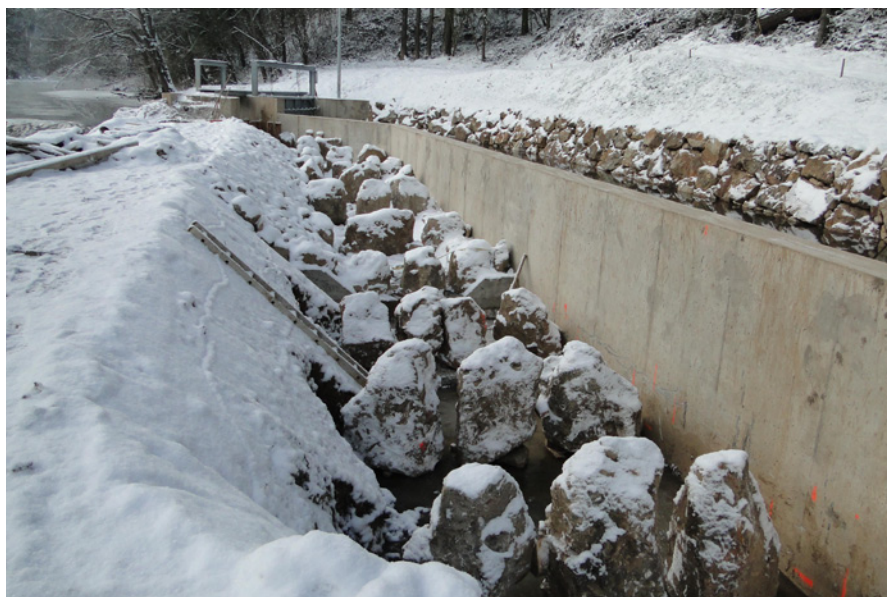
Realizace přírodě blízkého obtokového koryta rybího přechodu na Klabavě ř. km 2,269. Foto Kateřina Kujanová
