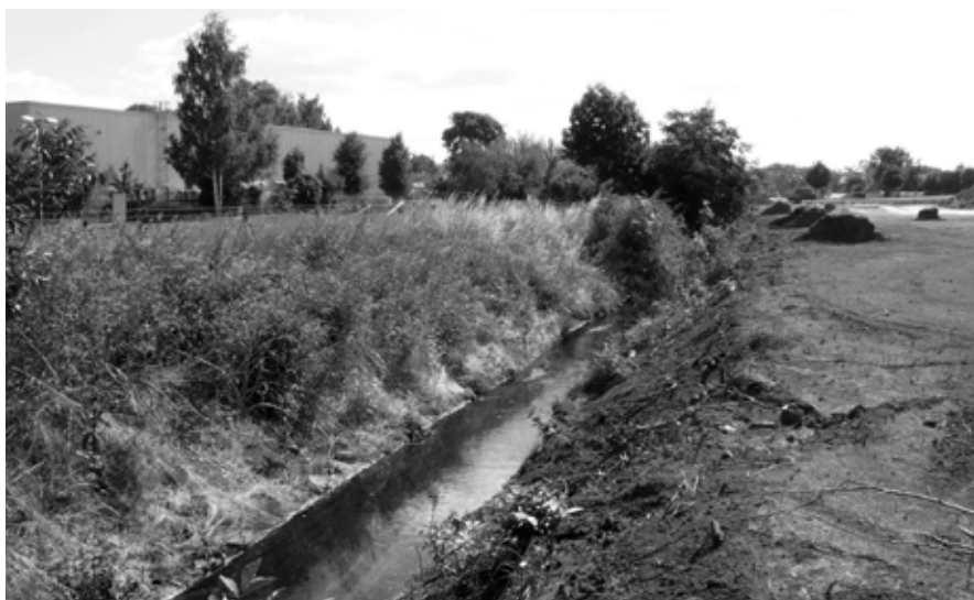
Litovický potok v Hostivicích při zahajovací práci. Produktem starší technické úpravy byla přímá trasa, lichoběžníkový průřez, opevnění dlažbou, minimální tvarová a hydraulická členitost, většinou výrazné zahloubení proti okolnímu terénu. Foto Tomáš Just
