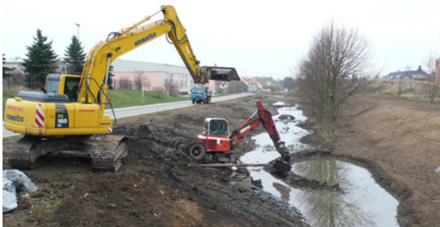
Podzim 2014 – první fáze prací v prvním úseku revitalizace. U hostivické školy již bylo rozsáhlým odtěžením zemin rozšířeno hlavní koryto potoka, následuje rozvolňování kynety. Foto Tomáš Just
