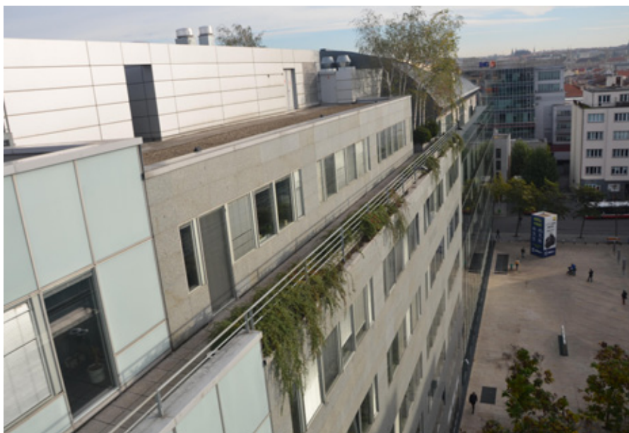
Obr. 2 Truhlíková zeleň může poskytovat potenciál pro alespoň základní oživení budovy a dá se s ní dále pracovat (Palác Anděl, Praha). Foto Ondřej Sedláček.
