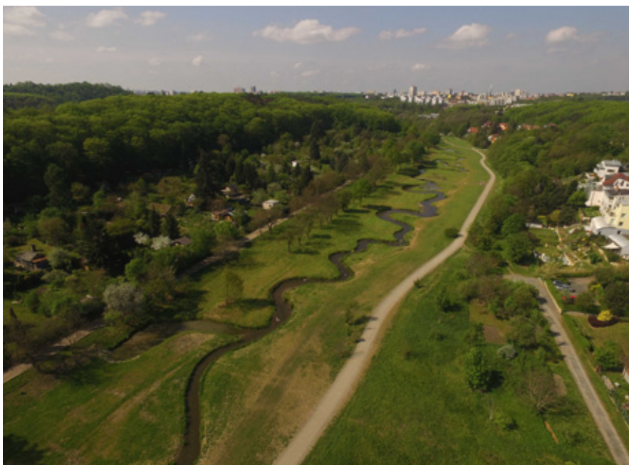
Nové koryto Rokytky nad Hořejším rybníkem. Foto www.andruvision.cz
