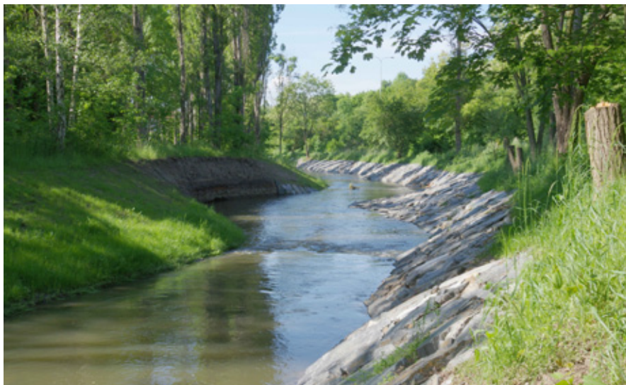
Balvanitá rovnánina nahradila původní betonové koryto. Foto Jiří Karnecki
