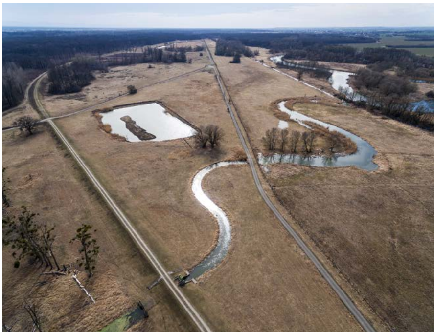
Nedaleko křižovatky Hrázové a Anglické cesty voda přes stavidlový objekt poldru zase opouští a teče zpátky k řece Dyji a jejím ramenům. Téměř obdélníková vodní plocha Hvězda je pozůstatkem těžby materiálu pro stavbu hráze poldru. Foto archiv autora
