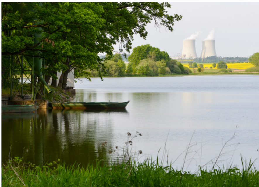
Krajina jižních Čech s novodobou dominantou - chladicími věžemi Jaderné elektrárny Temelín. Foto Tomáš Jůnek
