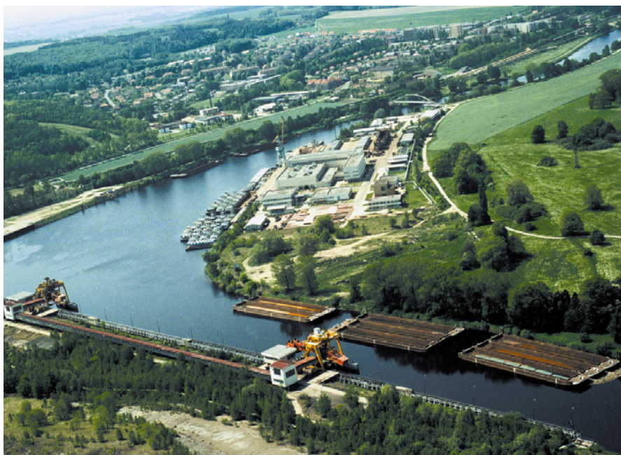
Port Chvaletice - Přístav Chvaletice je zatím posledním přístavem na Labi. Za ním je plánovaná výstavba plavebního stupně Přelouč, který má napojit izolovanou vodní cestu u Pardubic na evropskou síť vodních cest. Nu tuto zdrž by měl také navazovat koridor D-O-L. Zdroj WikiCommons
