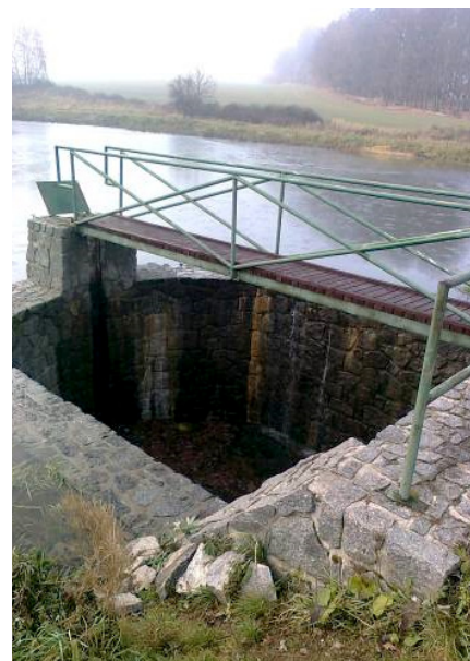
Na Brtnickém potoce se nacházejí dva rybníky oddělené dálnicí. Vyskytují se zde vydry. Na jedné straně potkají hezký dvojitý betonový propustek, který ovšem na druhé straně ústí do výpusti rybníka šachtovitěho typu o výšce cca 2,5 m. Tomu se říká dead end. Foto Marie Brůčková
