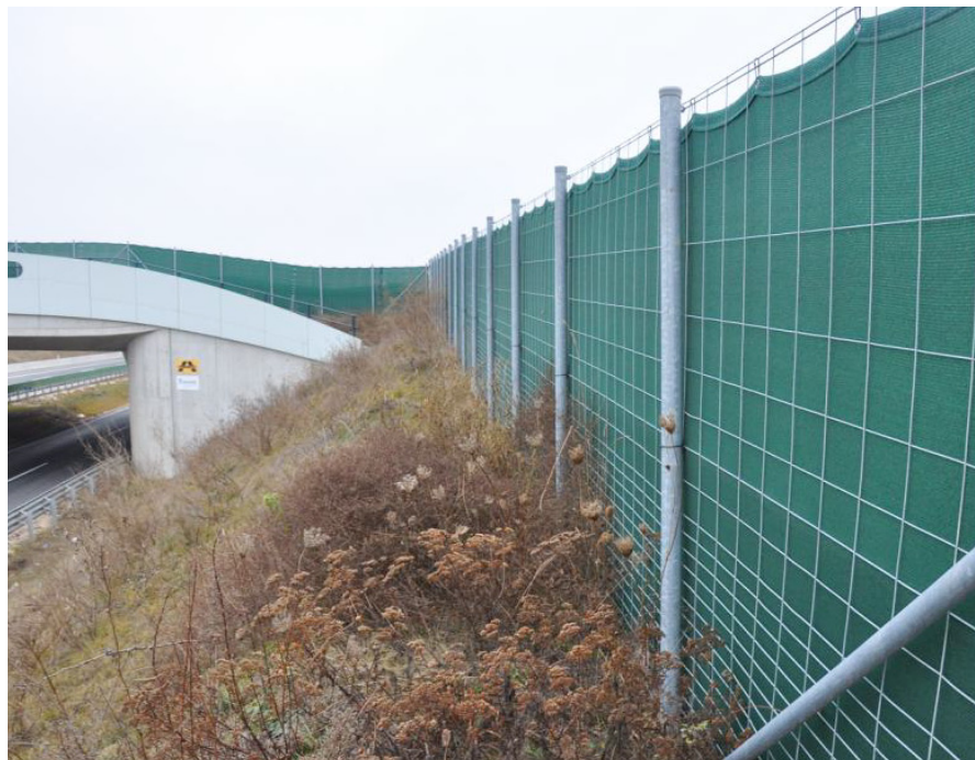
Odstínění mostu u Vídně. Protioslnivá a protiprůletová zábrana vyrobená z venkovní krycí tkaniny. U Vídně. Foto Radim Míšaček
