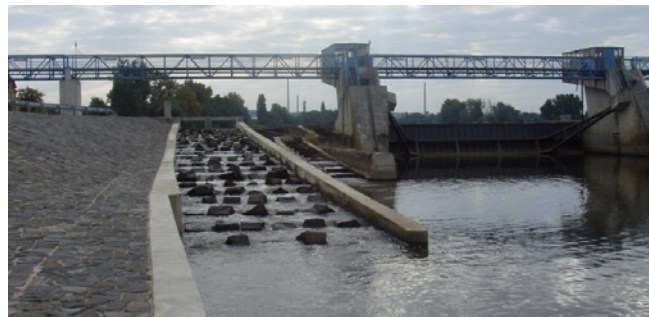
Vydařený rybí přechod typu rampa (Labe – Štětí)
