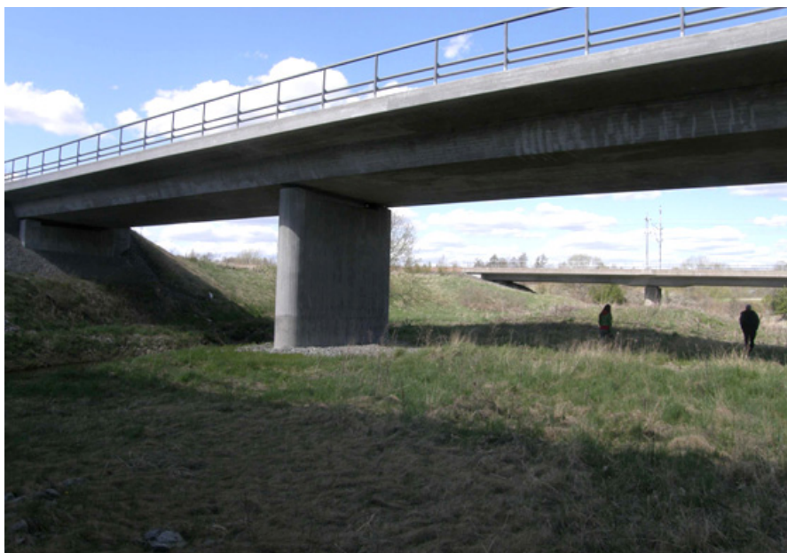
Ekodukt u Vasteras ve Švédsku - při výstavbě nové dálnice projektanti sami navrhli nový ekodukt, který navazuje na tunel, který se klene přes nedalekou železnici. Vznikla tak jednolitá migrační trasa přes obě překážky. Foto Simona Poláková
