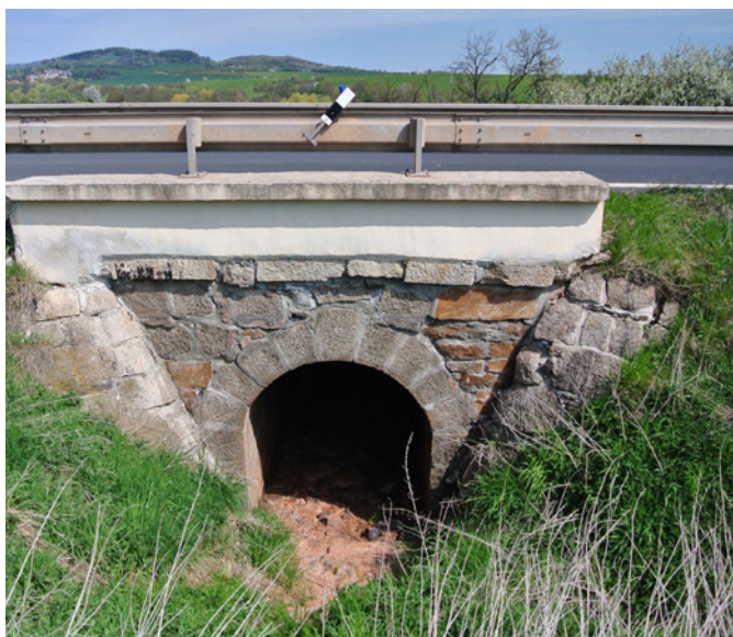
Obr. 5 a 6. Na obrázcích je propustek na stávající silnici I/6 o rozměrech 1,5 x 1,5m dlouhý 11,5m. Světlost je I = 0,2 . Ač je to k nevíře, je tento propustek běžně využíván srncem, prasetem a celou řadou dalších menších druhů. Foto Vlastimil Bogdan
