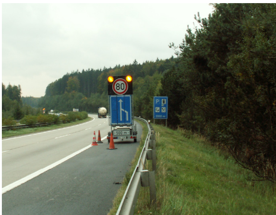
D1 - Dálnice D1 v místě plánovaného rozšíření u Jihlavy, které zasáhne EVL Vysoký kámen u Smrčné. Foto Ondřej Volf
