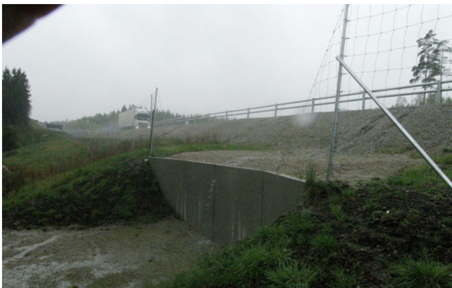
Seskokový bod neboli jump junction. Moderní dálnice bývají oplocené, aby se zabránilo vstupu zvířat na vozovku. Pokud se ale zvířeti podaří plot překonat, ocitá se v pasti, protože z jedné strany má plot a z druhé vozovku. Tuto situaci řeší tzv. seskokové body, kde mohou zvířata seskočit z krajnice. Foto Simona Poláková
