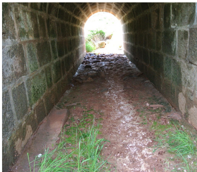
Obr. 5 a 6. Na obrázcích je propustek na stávající silnici I/6 o rozměrech 1,5 x 1,5m dlouhý 11,5m. Světlost je I = 0,2 . Ač je to k nevíře, je tento propustek běžně využíván srncem, prasetem a celou řadou dalších menších druhů. Foto Vlastimil Bogdan
