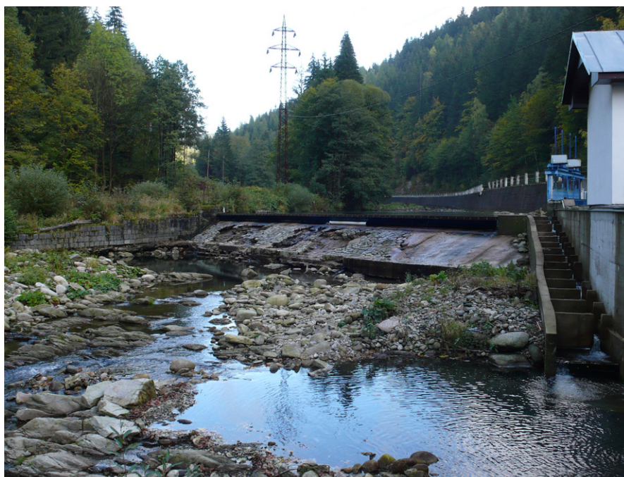
Jez na Labi s malou vodní elektrárnou v EVL Krkonoše. Foto Stanislav Březina
