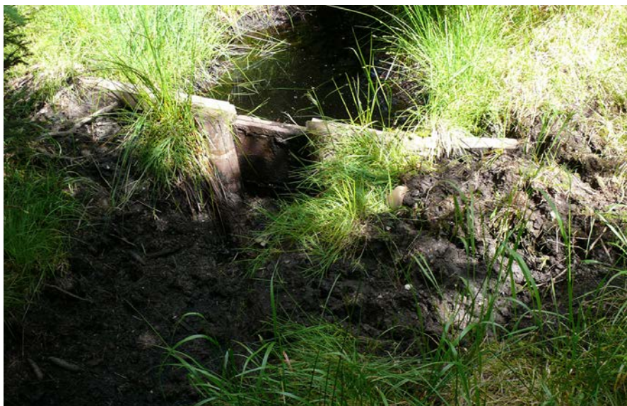
Jeden s hlavních sběrných kanálů po dvou letech od provedení opatření, 2012. Foto Pavel Kolibáč
