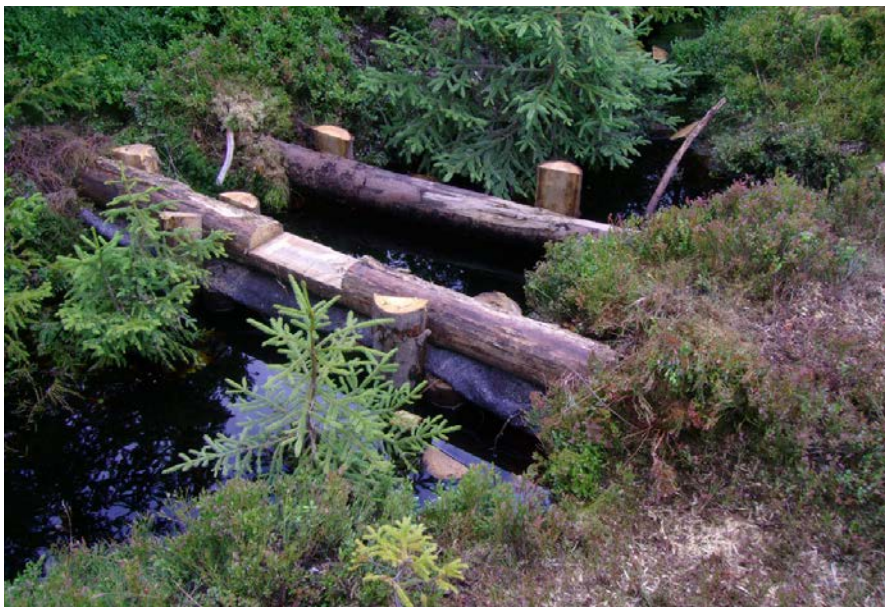
Jeden s hlavních sběrných kanálů po dvou letech od provedení opatření, 2011. Foto Pavel Kolibáč
