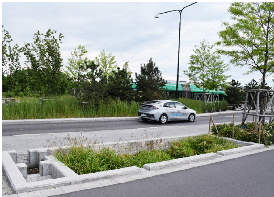
Obr. 4: Příklad uplatnění dvou zádržných prostorů u bioretenční plochy. Znečištěná voda z vozovky nejprve vteče do sedimentační vany, kde se předčistí a poté vteče do prvního zádržného prostoru, kde rostou rostliny a kde se dál voda pročišťuje a zároveň dodává živiny a vláhu vegetaci. Celý tento prostor je výrazně zahlouben, čímž je vytvořen druhý zádržný prostor určený výhradně pro extrémní deště. Neptunigatan, Malmö. Foto: Martin Vysoký
