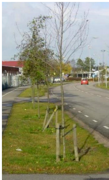
Obr 1: Stromová alej s průlehem pro zasakování dešťové vody z přilehlých povrchů, kde průleh po několika letech vykazuje nedostatečnou infiltrační schopnost a stromy mají velmi sníženou vitalitu a stagnaci v rozvoji i přesto, že mají dostatečný prokořenitelný prostor. Växjö. Foto: Magnus Nykvist
