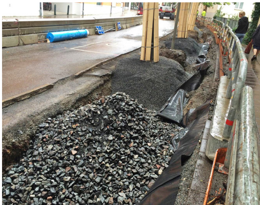
Obr. 3: Příklad uplatnění strukturního substrátu, který obsahuje makadam a biouhel. I mnozí zkušební experti mohou být při prvním pohledu na strukturní substrát zaskočení, jelikož tyto substráty, které se u prvků MZI uplatňují, neobsahují téměř žádnou zeminu. Stockholm. Foto: Björn Embrén
