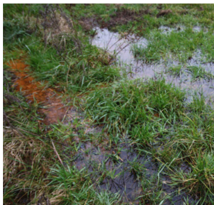
Obr. 3: Vývěr ucpané meliorace (vlevo rezatá skvrna), zemědělci přezdívaný „bouchačka“, Lutová, Třeboňsko. Životnost meliorací je na samém konci: vzniknou zde mokřady nebo vytvoříme dotaci na opravy skrytého potrubí? Foto David Pithart
